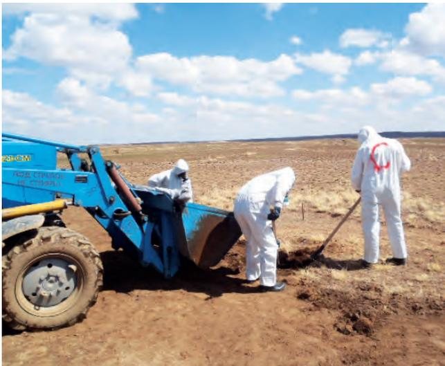
Использование ручного способа позволило уменьшить глубину изъятия грунта, что, в свою очередь, привело к снижению объемов изымаемых ОЯД. При этом, оставшаяся после снятия верхнего слоя активность грунта контролировалась спектрометристом, находившимся на участке ведения работ. В случае выявления повышенного содержания ОЯД изъятие грунта проводилось на большую глубину, а в некоторых случаях – за пределы изначально определенных контуров участка.
