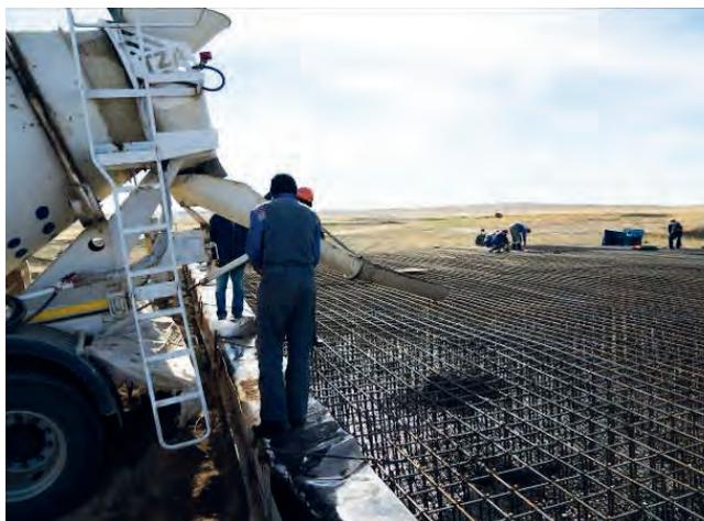
Армирование защитного колпака и заливка бетонной смеси
