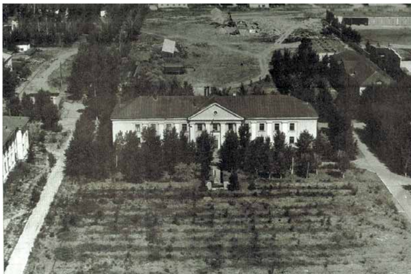
Территория Опытной-научной части, старое здание штаба (конец 50-х – начало 60-х годов), ныне здание административного корпуса ИРБЭ
