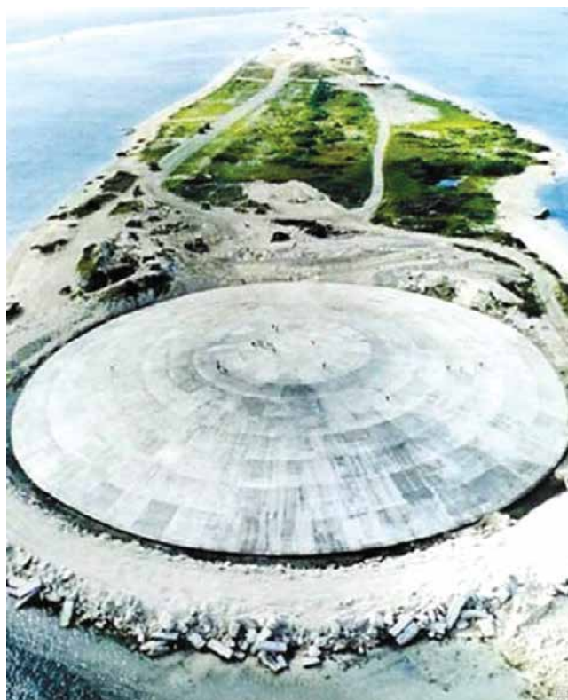
Защитное покрытие на атолле Эниветок
