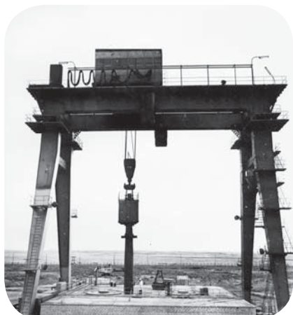
Установка перегрузочного контейнера на люк помещения досборки (пом. 03)
