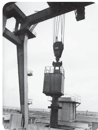
Установка контейнера на перегрузочный люк
