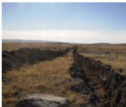
Траншея после завершения работ
