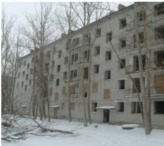
Здание бывшего жилого дома до начала работ, 2008 год
