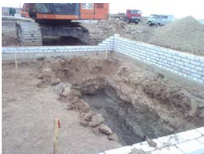
Разработка котлована экскаватором внутри помещения под фундамент оборудования.
