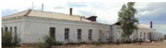
Здание во время реконструкции
