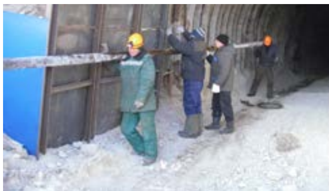
Установка магистрали для подачи сжатого воздуха зима, 2011 года
