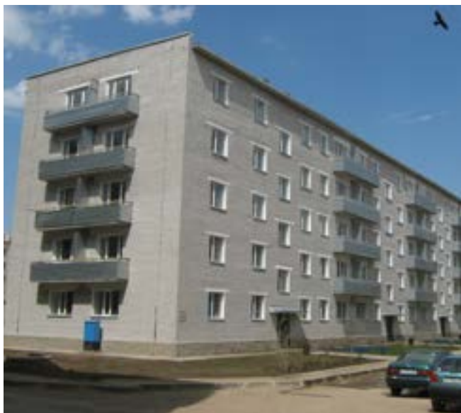
Здание жилого дома после восстановления, 2010 год
