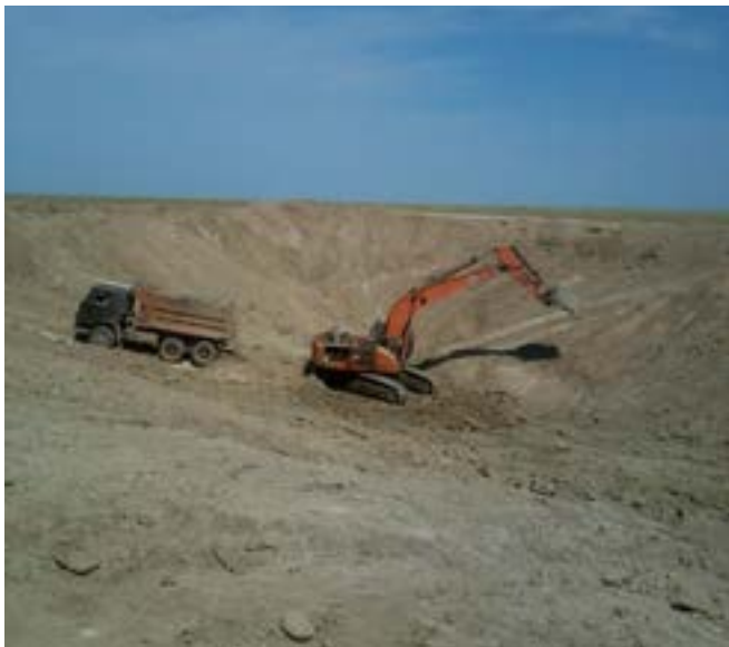
Разработка грунта экскаватором с погрузкой в автомобили-самосвалы
