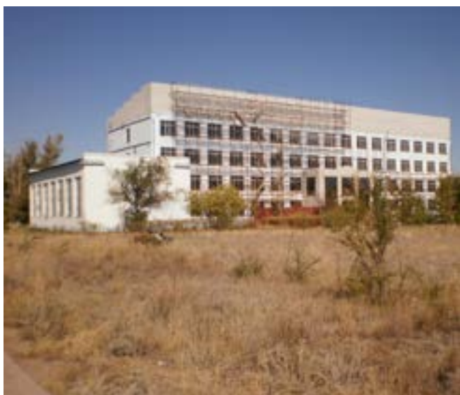
Здание во время реконструкции
