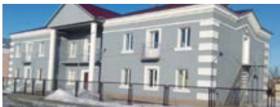
Вид фасада здания до и после ремонта
