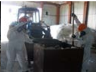
Извлечение мешков с ионизирующим грунтом
