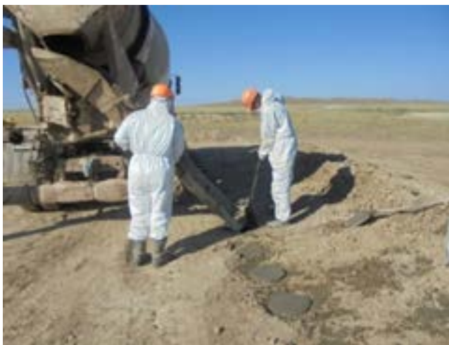
Бетонирование скважин
