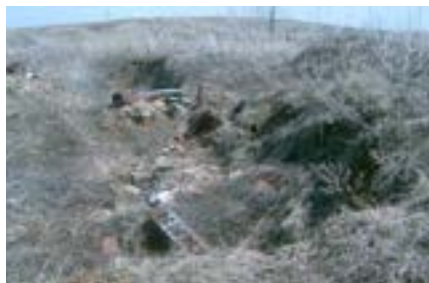
Вскрытые траншеи- хранилище для ТРО, состояние до ремонта
