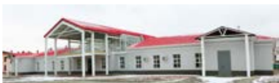
Здание после реконструкции
