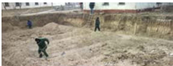
Устройство котлована, 2013 год
