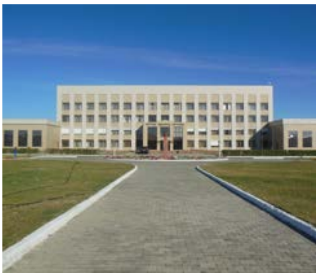
Здание после реконструкции
