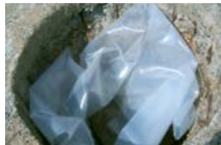
Хранилище для ампульных источников, вид до ремонта
