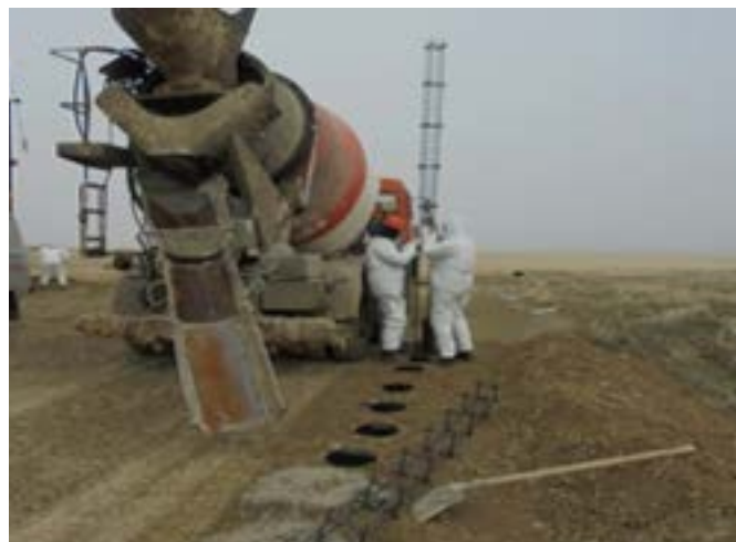
Армирование скважин
