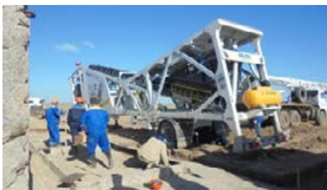
Подготовка основания под завод
