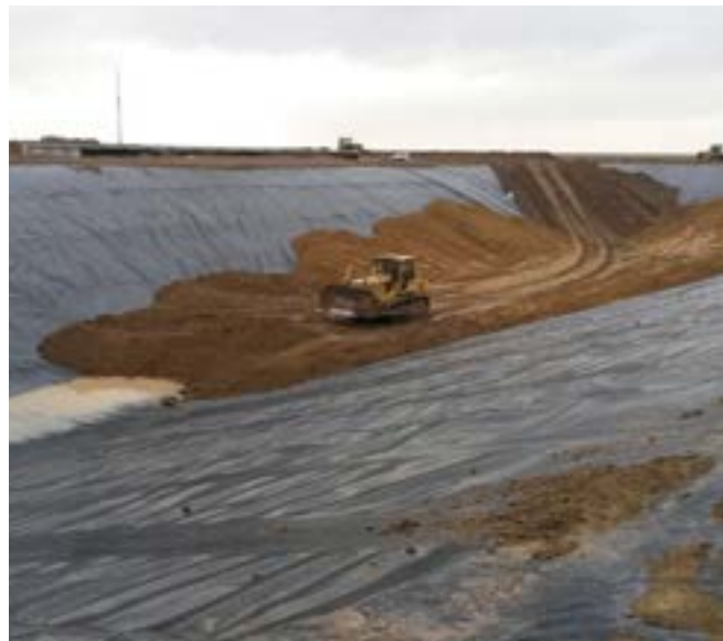
Устройство противофильтрационного слоя из глины
