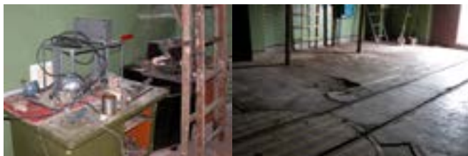
Состояние помещений и оборудования до ремонтных работ, 2004 год
