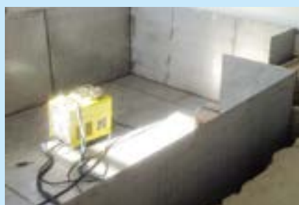
Работы по установке в котловане обшивки фундамента стальными листами
