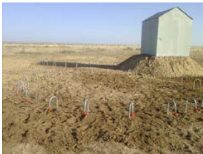
Радиально-лучевая система с аппаратным бункером после обратной засыпки
