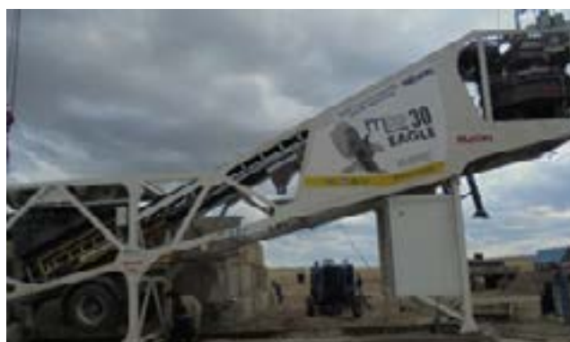
Основной элемент завода установлен на основание
