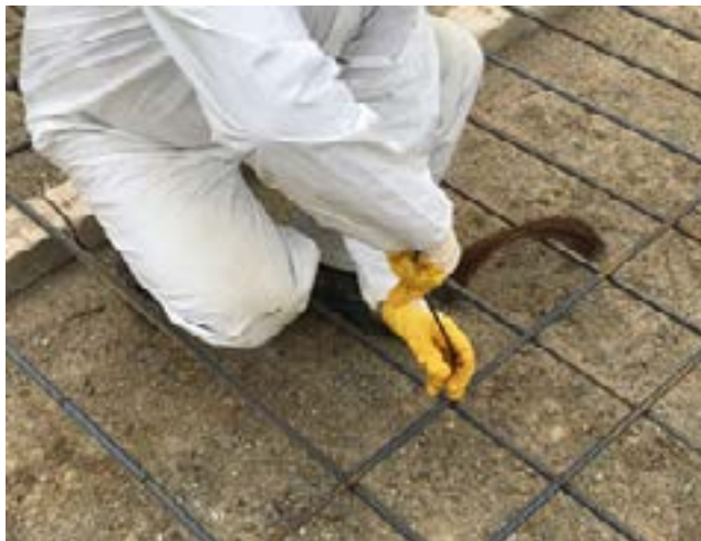
Изготовление сеток из арматуры
