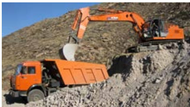
Погрузка чистого грунта в автосамосвалы
