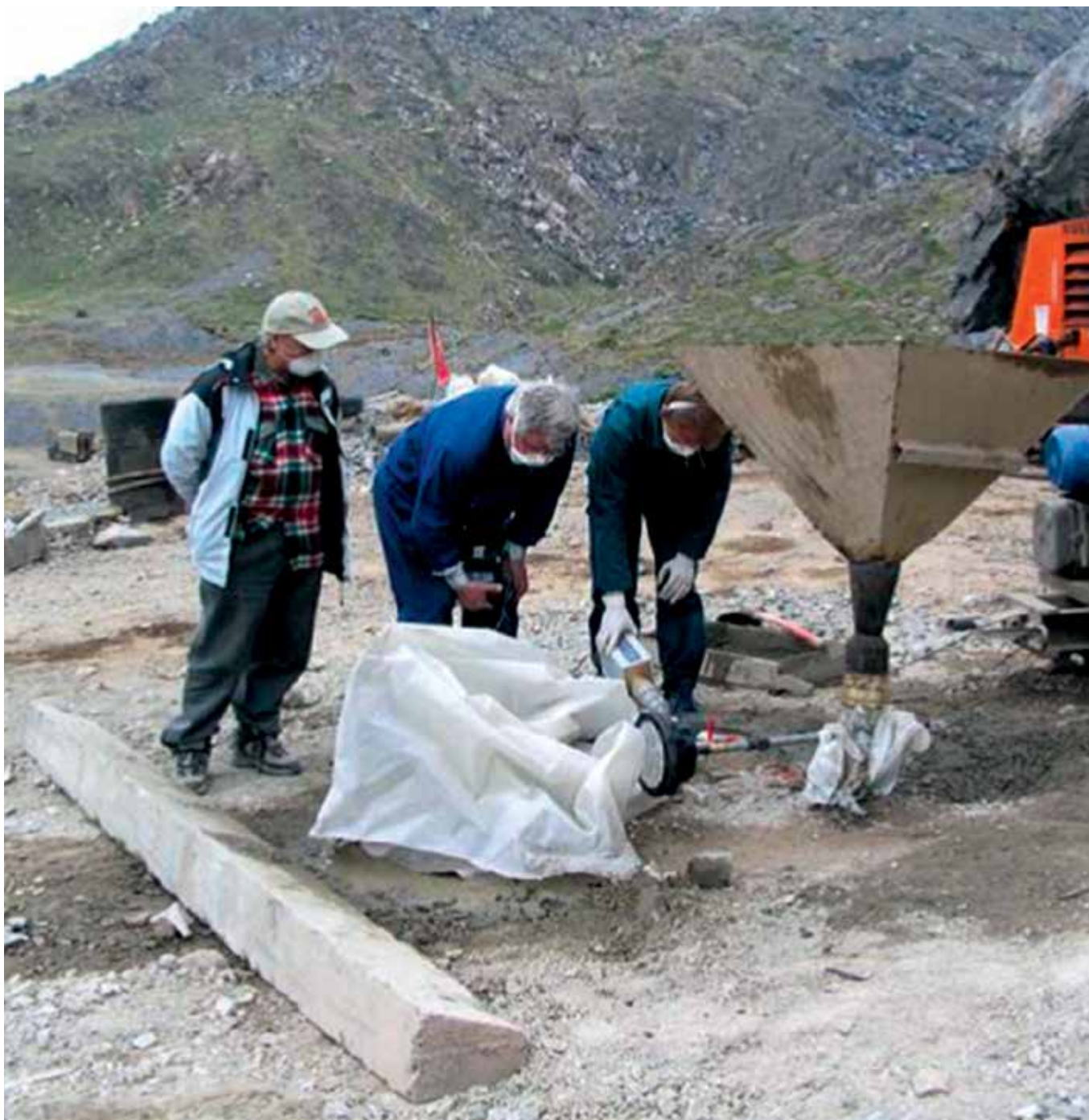
Радиационный контроль процесса заполнения контейнера «Колба» цементным раствором
