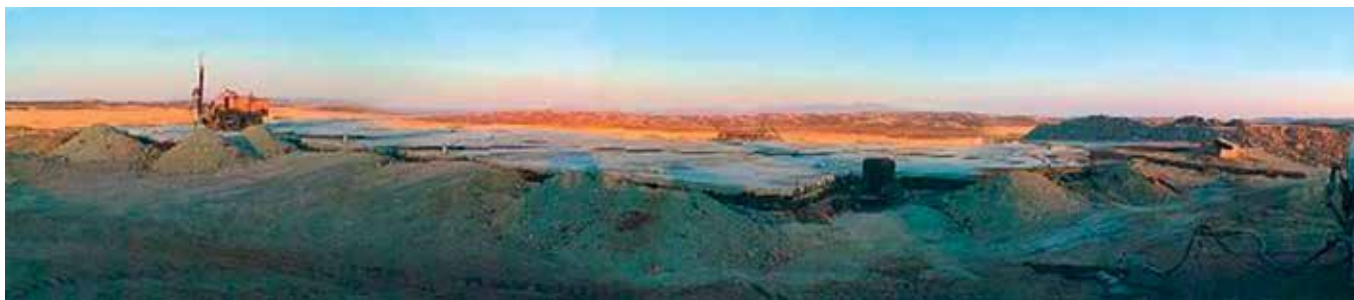
Вид поверхности саркофага после установки 4 рядов «аэродромных» плит
