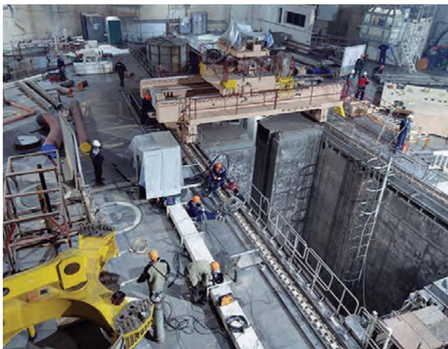
*Вид на герметичное отделение реактора 4 блока Ростовской АЭС во время монтажа – бассейн выдержки ОЯТ, перегрузочная машина и за ней – шахта реактора*
