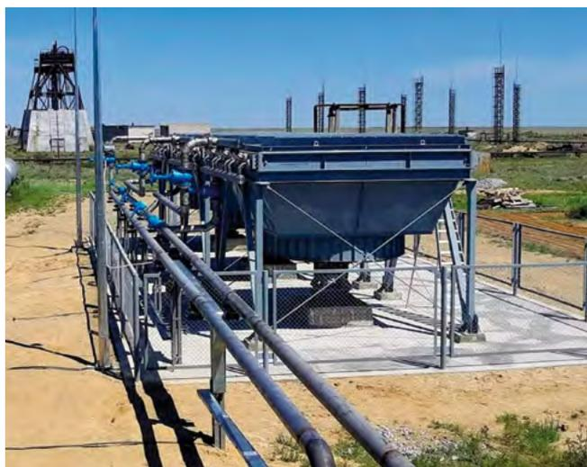
Внешний вид дополнительной системы охлаждения теплоносителя реактора ИВГ.1М (слева – группа вентиляторных градирен, справа – насосная станция, теплообменник, емкость хранения этиленгликоля)
