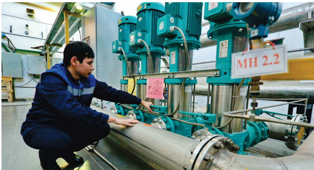
Система охлаждения токамака КТМ
