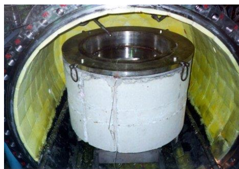
Рисунок 8. Ловушка расплава АЗ
