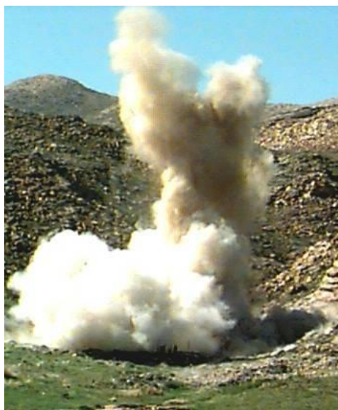
Рисунок 16. Ликвидация штольни взрывом
