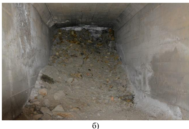
Рисунок 3. Общий вид на здание возле шахты 4 (а) и засыпанный вход (б) в туннель с фрагментами руды
