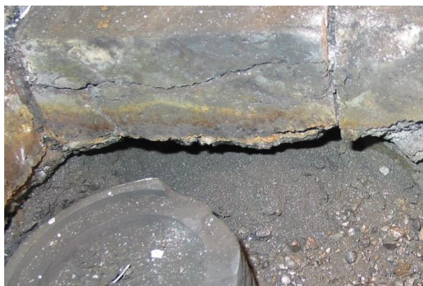
Рисунок 4. Область отбора материала эрозии блоков
