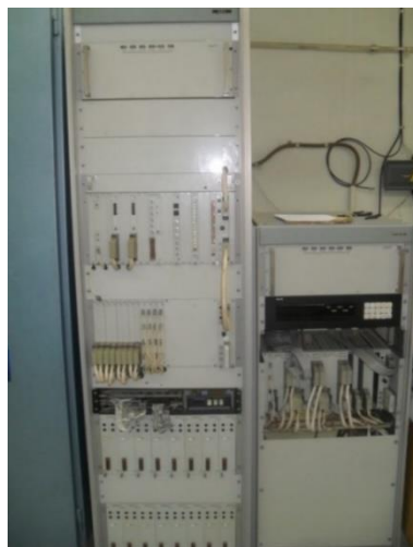
Рисунок 3. Внешний вид аналоговых преобразователей АСВТ-М
