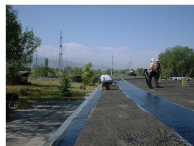
в – Ремонт мягкой кровли
