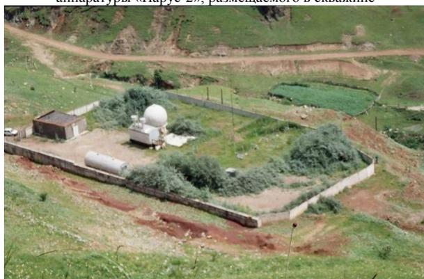
в – автоматическая сейсмическая станция, передающая непрерывно информацию по спутниковому каналу связи
