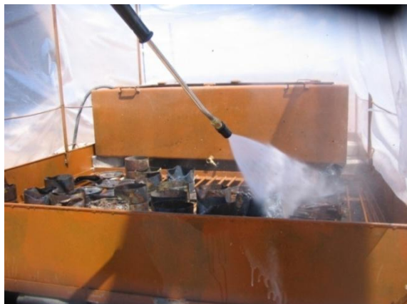
Рисунок 9. Дезактивация металлических элементов
