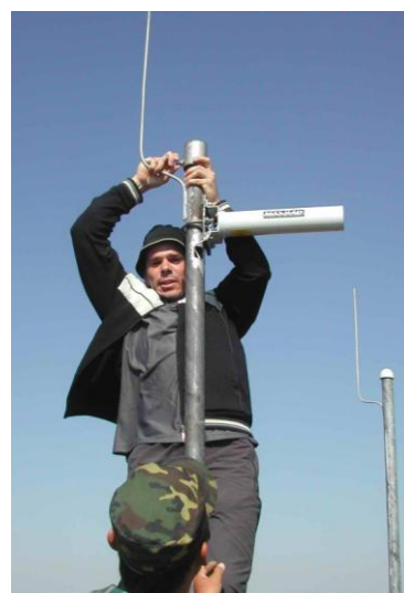
Рисунок 5. Станция AS059-Актюбинск: приборное сооружение (слева - оголовок скважины, в которой установлен сейсμοприемник, справа - электронная часть оборудования); монтаж антенны
