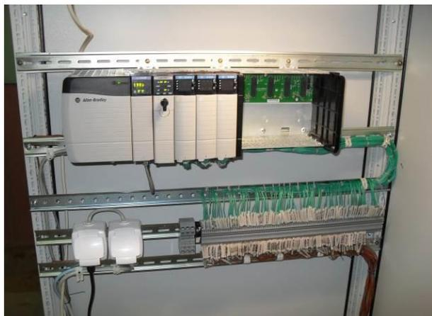
Рисунок 3. Шкаф с контроллером системы САУ
