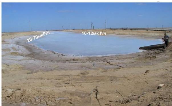
Рисунок 2. Различие радиоактивной загрязненности берегов узкой карты-отстойника пластовых вод нефтедобывающего предприятия
