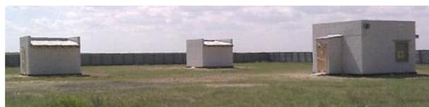
Рисунок 3. Внешний вид магнитной станции (слева – технический павильон, в центре – павильон вариационных измерений, справа – павильон абсолютных измерений)
